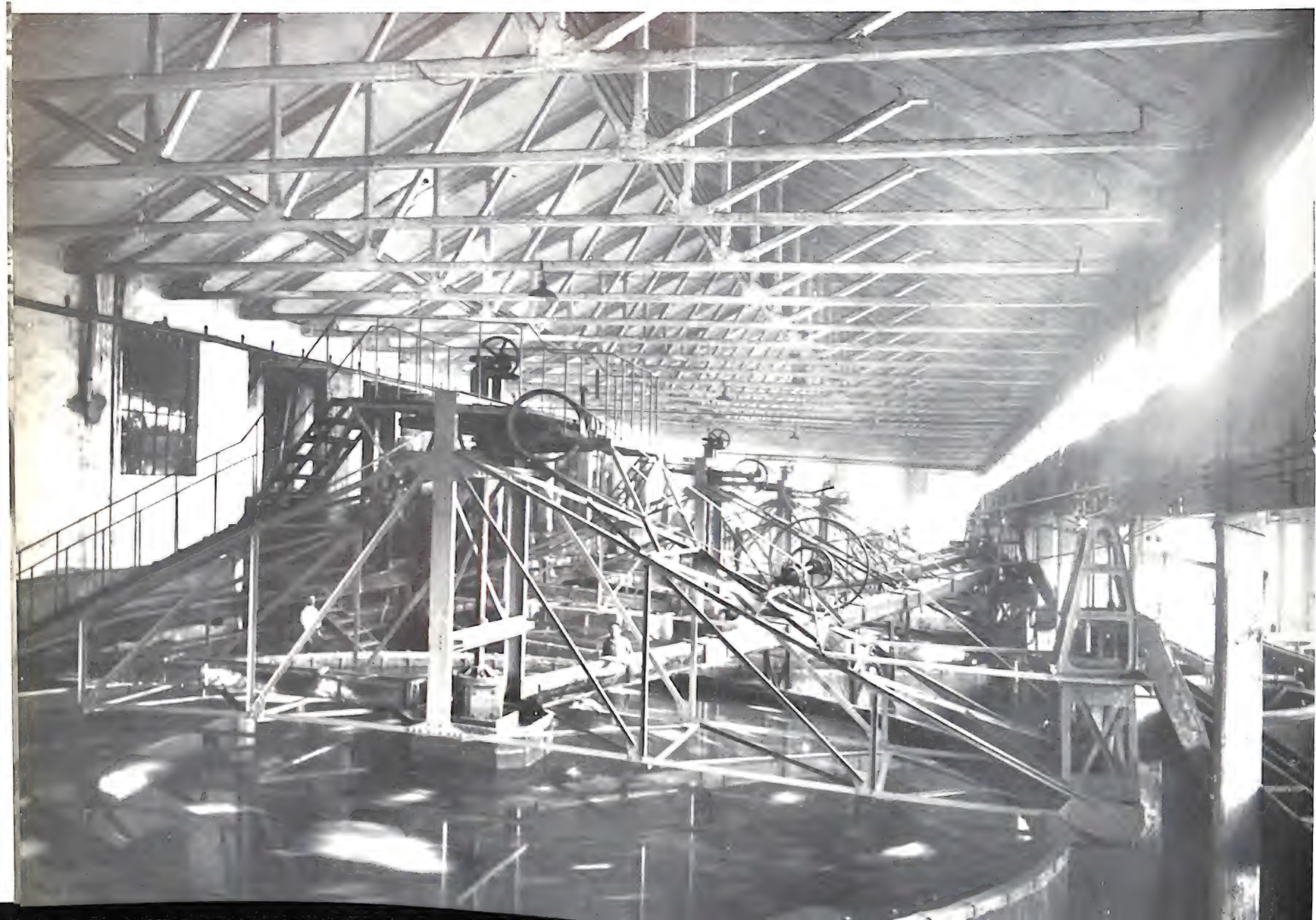
Monteponi - Impianto per lo zinco elettrolitico - Decantatori Dorr.
